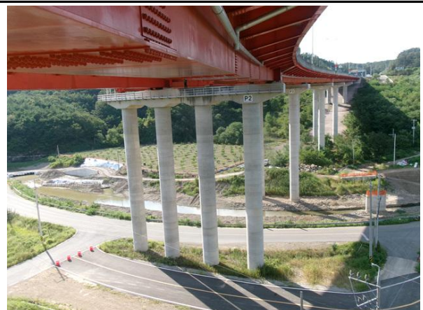
교각 P2 기초 전경
