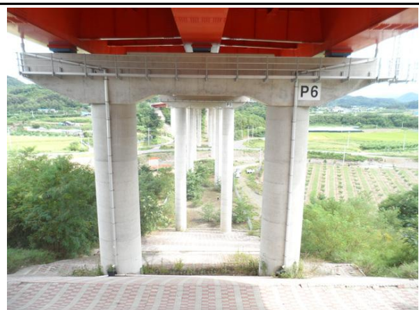
교각 P6 기초 전경
