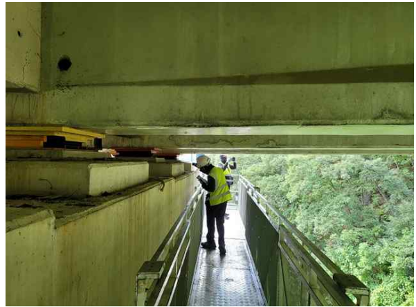
굴절작업차를 이용한 부재치수 현장측정
