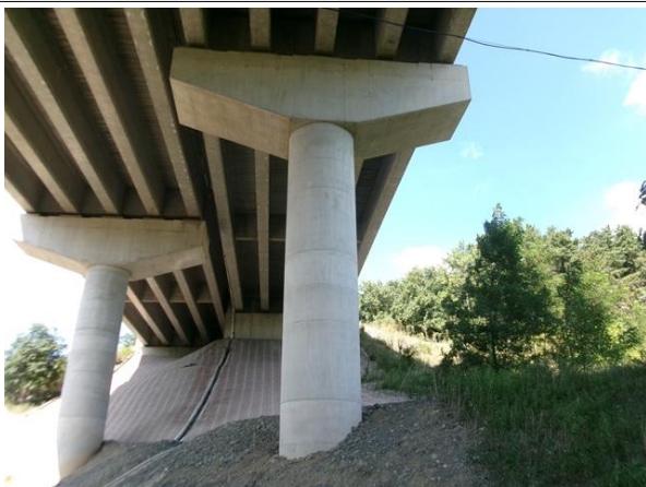
교각 P1 기초 전경
