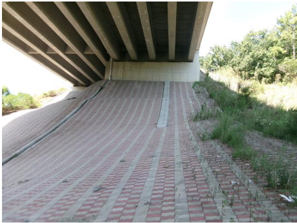
교대 A1 기초 전경
