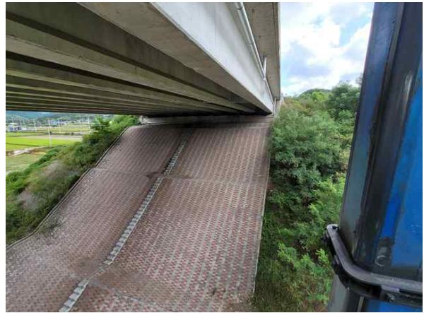
교대 A2 기초 전경
