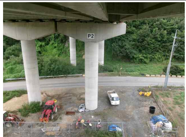
교각 P2 기초 전경
