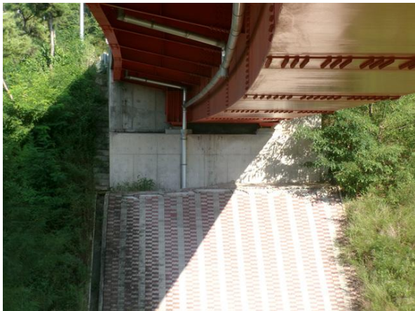
교대 A1 기초 전경
