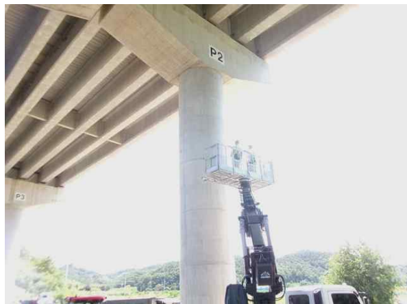
고소차를 이용한 근접조사
