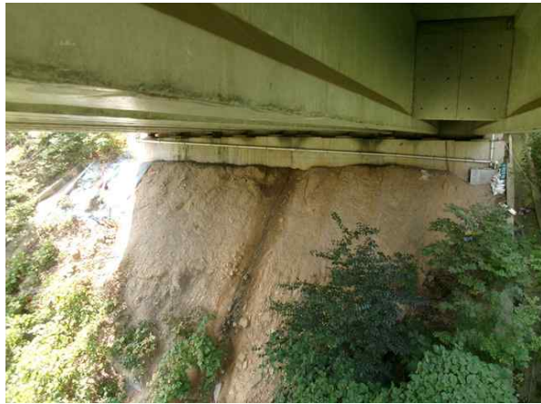
교대 A1 기초 전경
