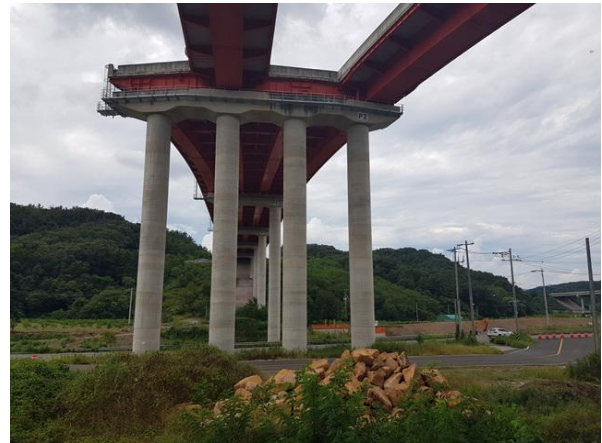
교각 P2 기초 전경
