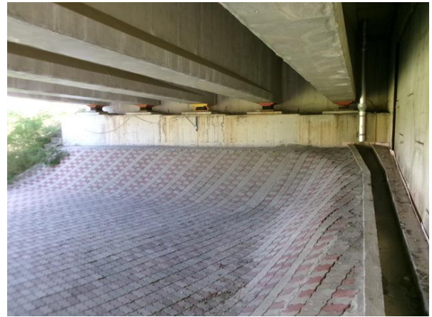
교대 A2 기초 전경
