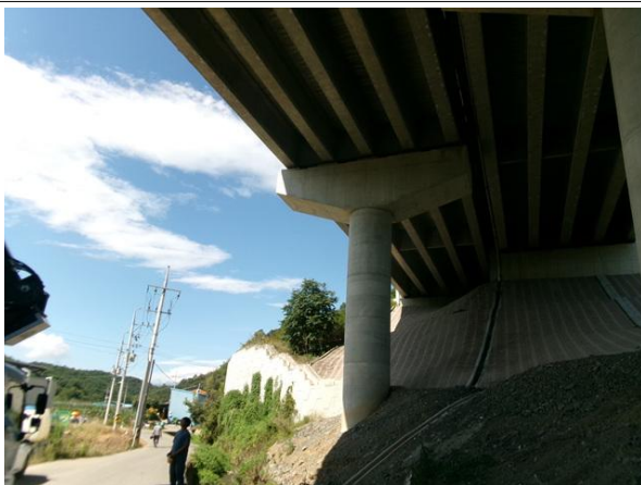
교각 P1 기초 전경
