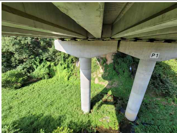
교각 P1 기초 전경
