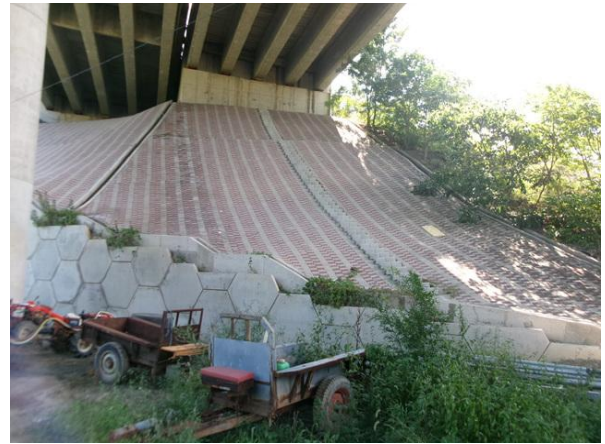
교대 A2 기초 전경
