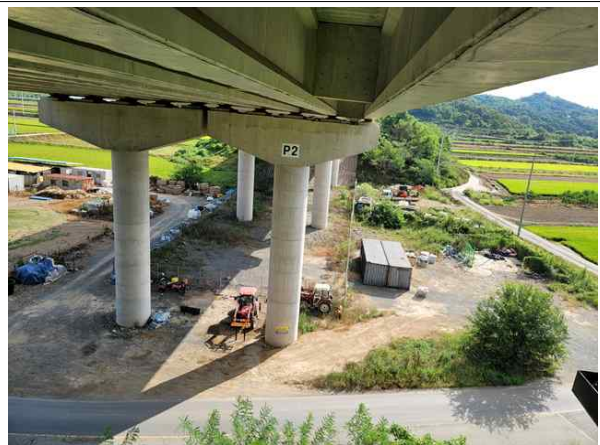
교각 P2 기초 전경
