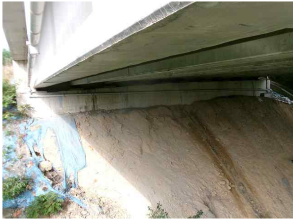
교대 A1 기초 전경
