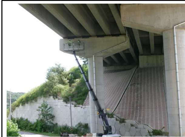
고소차를 이용한 근접조사
