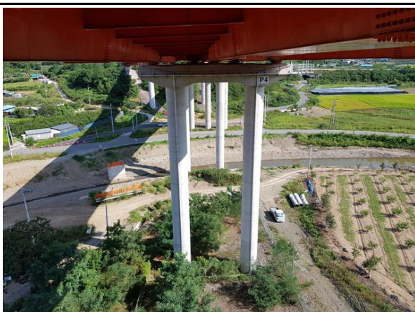
교각 P4 기초 전경
