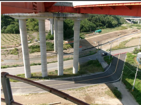
교각 P2 기초 전경
