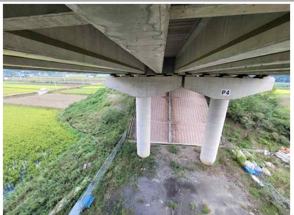
교각 P4 기초 전경
