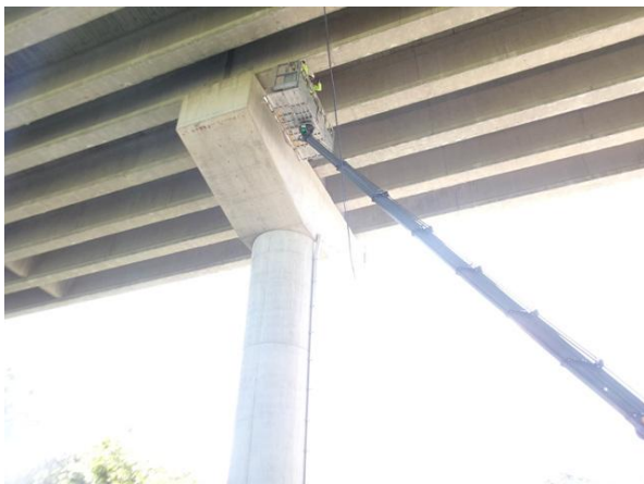
고소차를 이용한 근접조사
