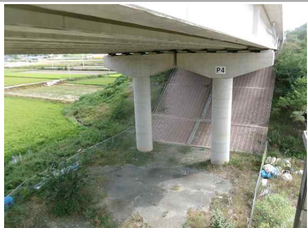
교각 P4 기초 전경
