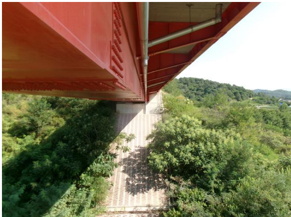
교대 A1 기초 전경
