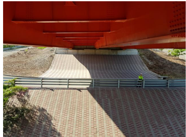
교대 A2 기초 전경
