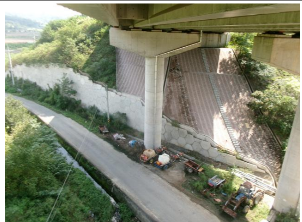
교각 P2 기초 전경
