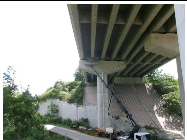
고소차를 이용한 근접조사
