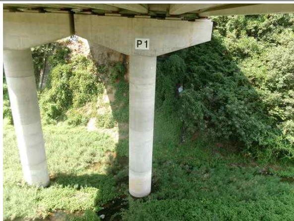
교각 P1 기초 전경
