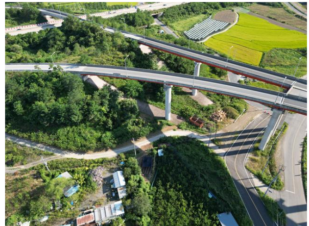
교대 A1 기초 전경
