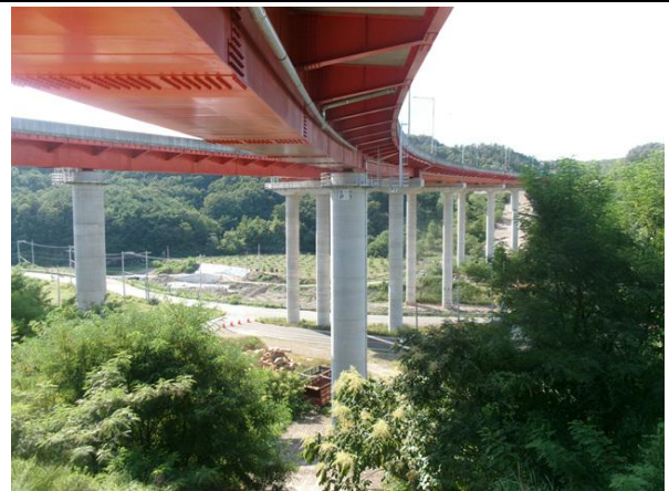
교각 P1 기초 전경
