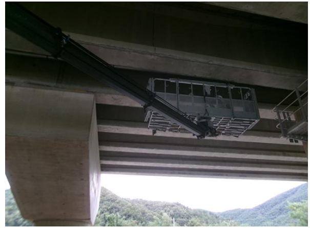
고소점검차를 이용한 근접조사
