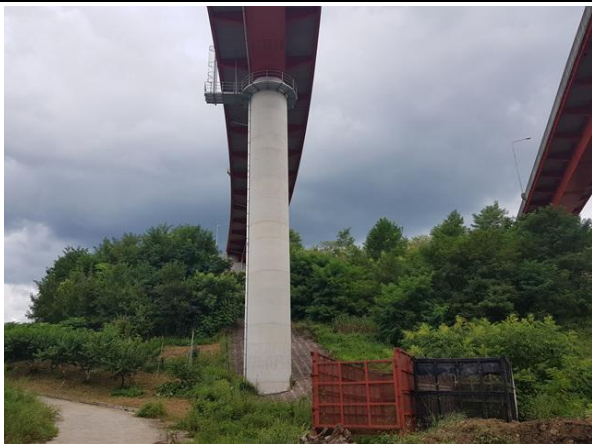
교각 P1 기초 전경
