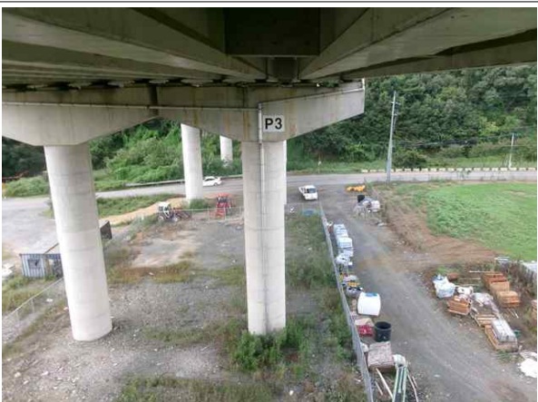
교각 P3 기초 전경
