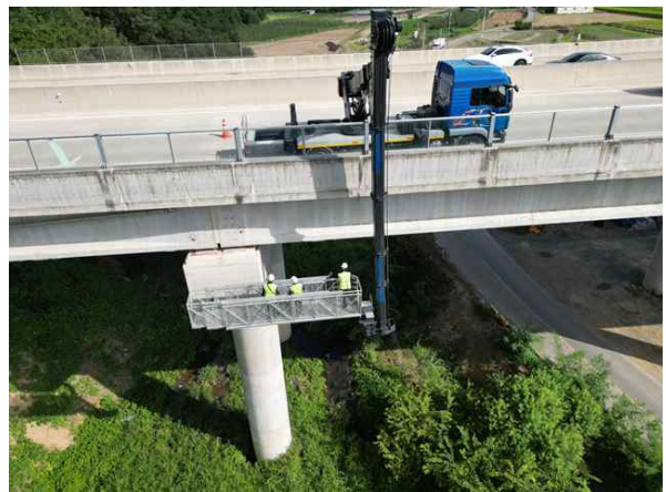
굴절작업차를 이용한 근접조사
