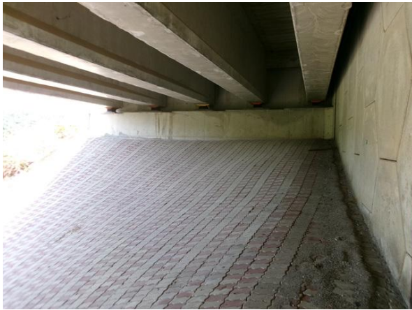
교대 A1 기초 전경
