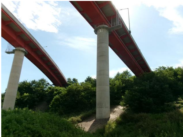
교각 P1 기초 전경
