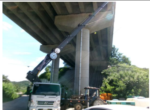
교각 P2 기초 전경
