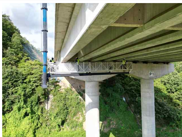
굴절작업차를 이용한 근접조사
