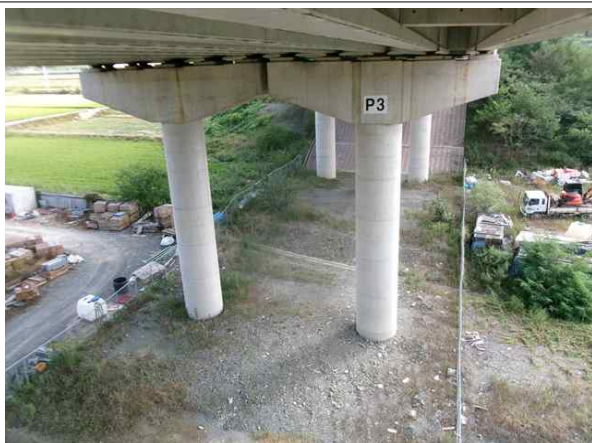
교각 P3 기초 전경
