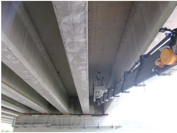
고소점검차를 이용한 근접조사
