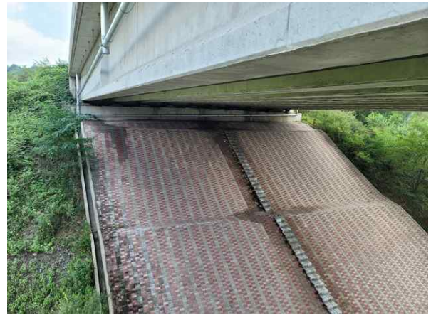
교대 A2 기초 전경
